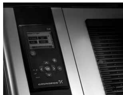
Fig. 86 Interfaccia utente di Grundfos CUE
