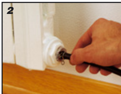
2 Avvitare il tubetto di scarico in dotazione
