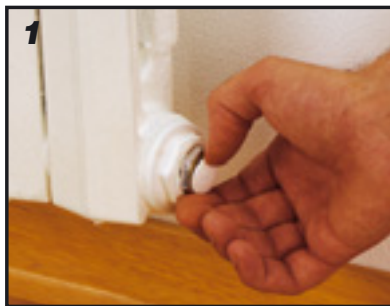
1 Togliere il cappuccio di protezione
