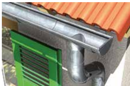
Sigillatura di grondaie
